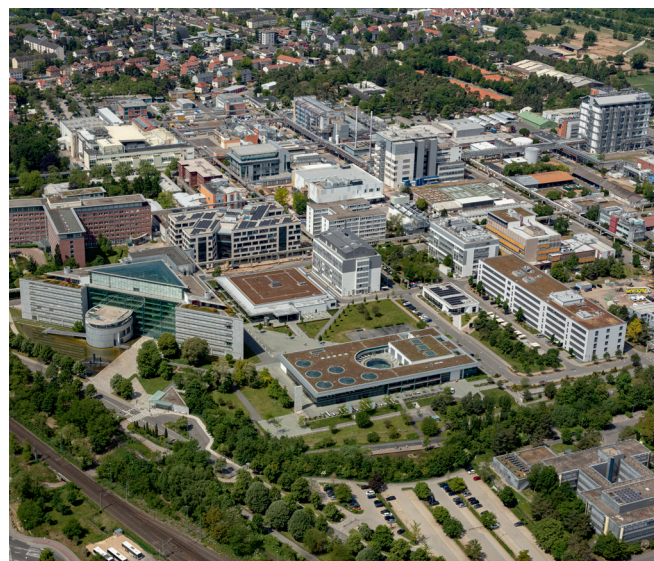
Luftaufnahme Standort Ingelheim © Boehringer Ingelheim
